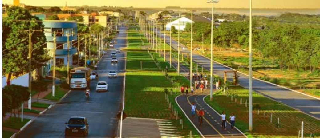
Ciclovias: são 18,5km de pista construída sobre os canteiros, com 4m de largura divididos em áreas para pedestres e ciclistas.
